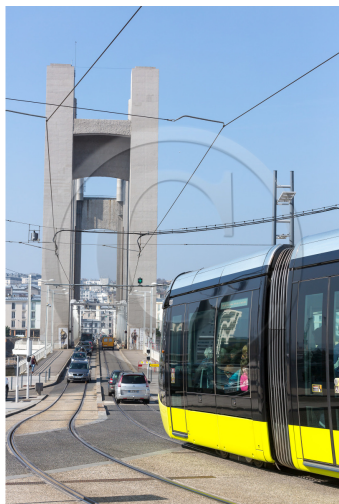
Pont de la recouvrance à Brest
