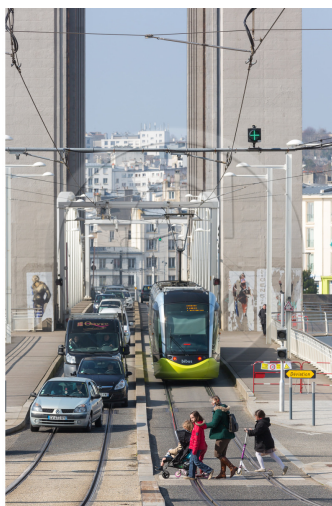
Pont de la recouvrance à Brest
