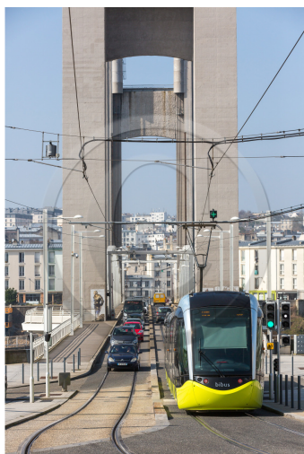
Pont de la recouvrance à Brest
