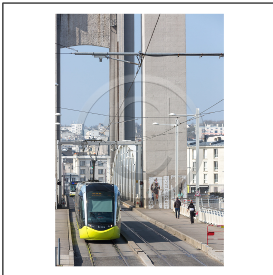
Pont de la recouvrance à Brest
